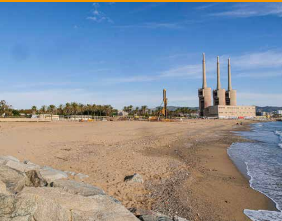
📍 L'estació està ja en fase de construcció a Sant Adrià de Besòs i entrarà en funcionament durant el primer trimestre de 2022
